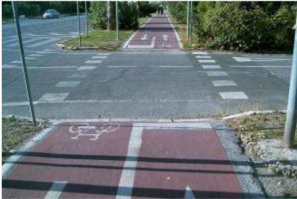
Attraversamento ciclabile semplice
